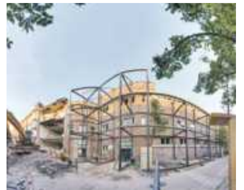
De monumentale gevel wordt gestut met een indrukwekkende stelling
