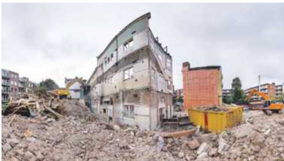
Achter de oude gevel komt een heel nieuw gebouw te staan
