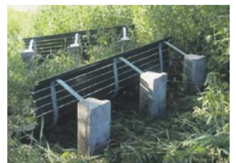
Alle banken en dat waren er zes, die hier stonden, zijn uit de grond gerukt
