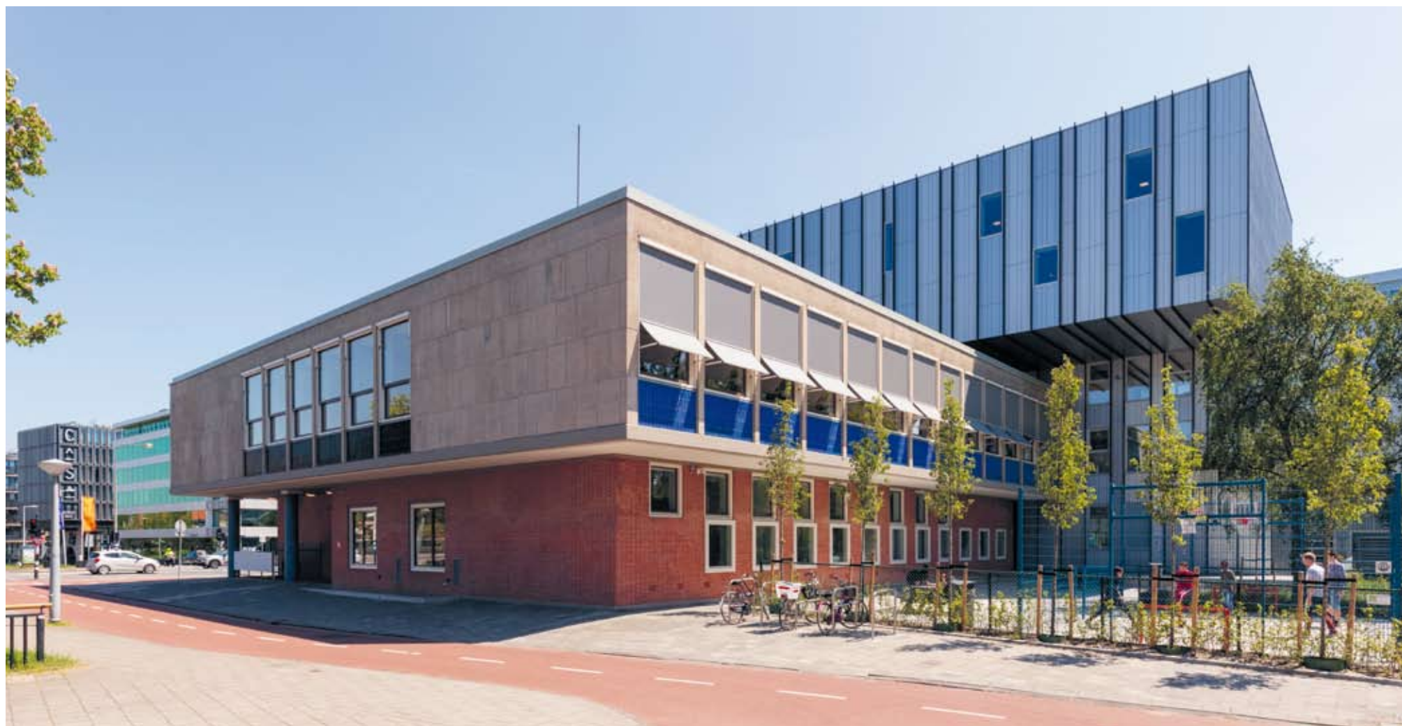
Het nieuwe markante onderkomen het Orion College Amstel
