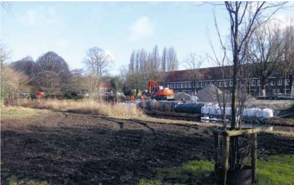
Het Galileiplantsoen is plotseling veranderd in een zandbak en een plek met volop werkzaamheden. Bewoners zijn overvallen. De lokale politiek laat het afweten. In de volgende Dwars meer hierover.
