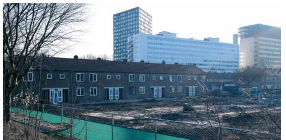
Het slopen van de rijtjeswoningen gaat snel
