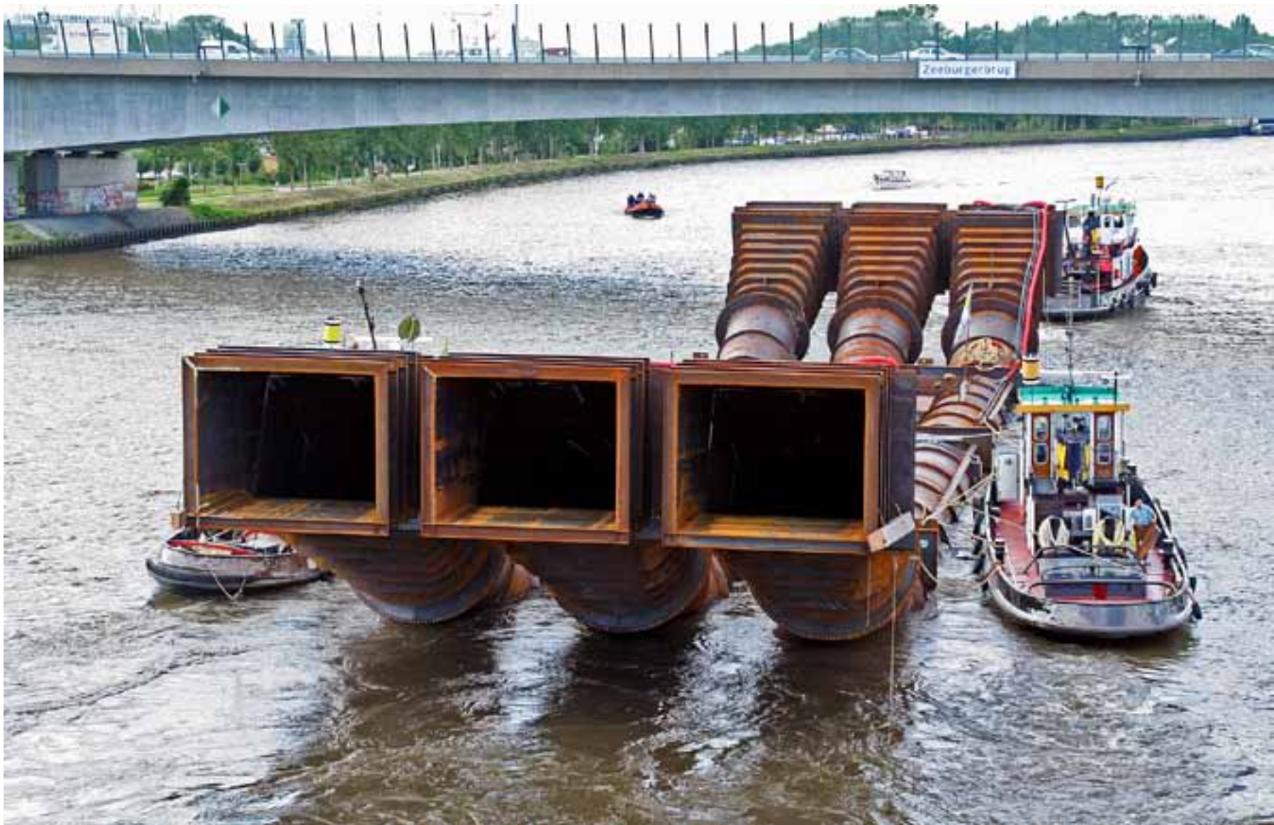
Het sifon werd op 8 september 2006 door het Amsterdam-Rijnkanaal vervoerd om daar afgezonken te worden.
