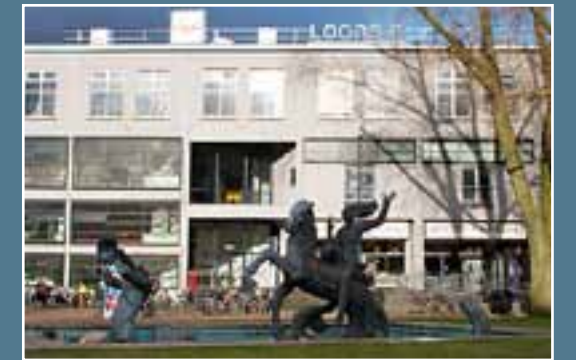
De ingang van Loods 6 aan de KNSM-laan.
