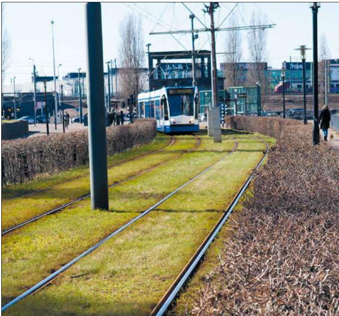
Gras tussen de rails van tramlijn 10 voor tijdelijke opvang van regenwater
