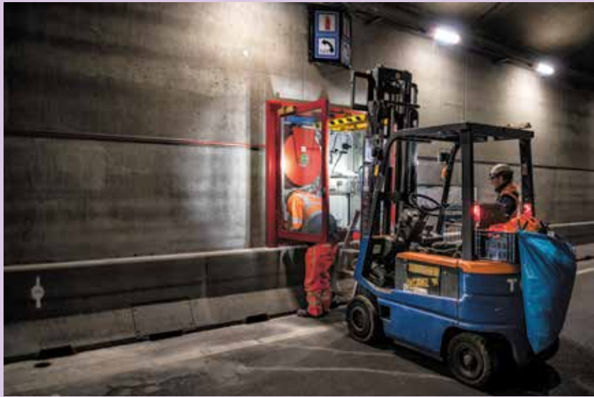
Hier wordt een nieuwe hulpkast geplaatst. Een hulpkast is onder andere voorzien van een noodtelefoon, brandslanghaspel en een wateraansluiting voor de brandweer. Ook de pictogrammen boven de hulpkasten zijn vervangen.
