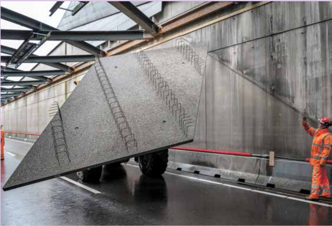
De betonnen voorzetwanden worden geplaatst met een shovel voorzien van een vacuüm unit (zuignap). Na het plaatsen wordt achter de wanden beton gestort.
