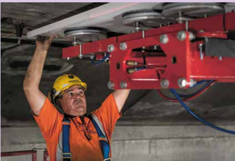
Ook de voegovergangen worden voorzien van hittewerende beplating. Het tillen van deze panelen gebeurt met behulp van een machine met een vacuümsysteem (zuignap)
