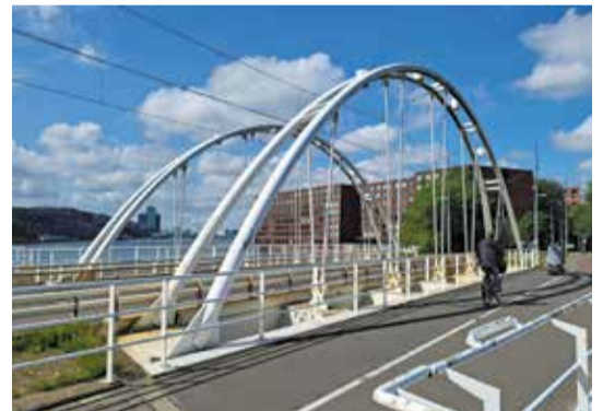
Brug op de Verbindingsdam
