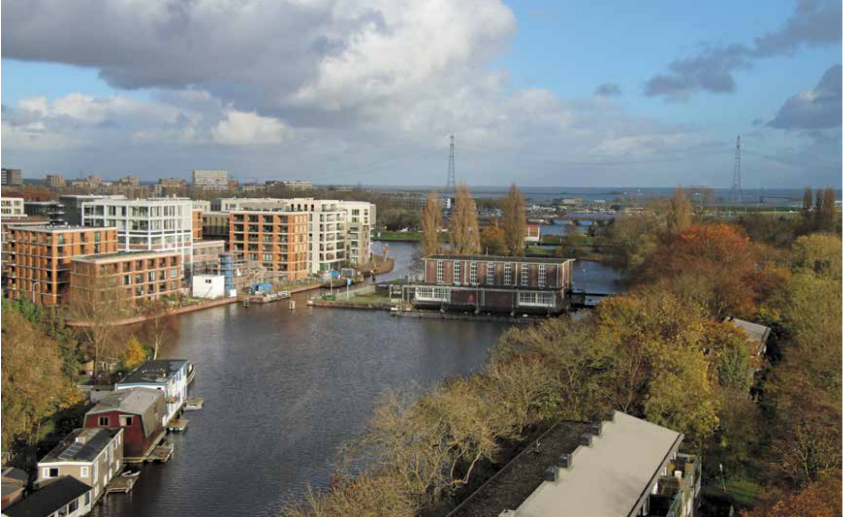
Gemaal Zeeburg ligt aan het eind van het Lozingskanaal naast de Zeeburgerdijk – daarachter de Voorboezem, het Amsterdam-Rijnkanaal en het IJmeer
