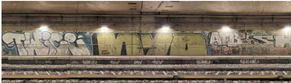
Artistiek vandalisme in de metrotunnel
