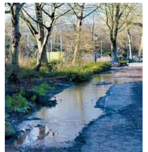
Wateroverlast en werkzaamheden
