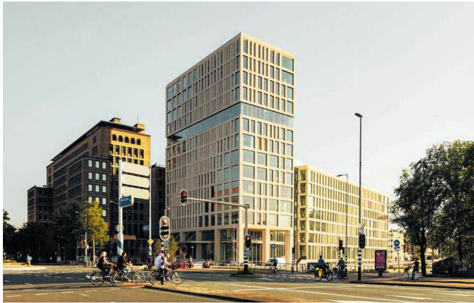
Het Jakoba Mulderhuis op de hoek van Wibautstraat en Mauritskade
