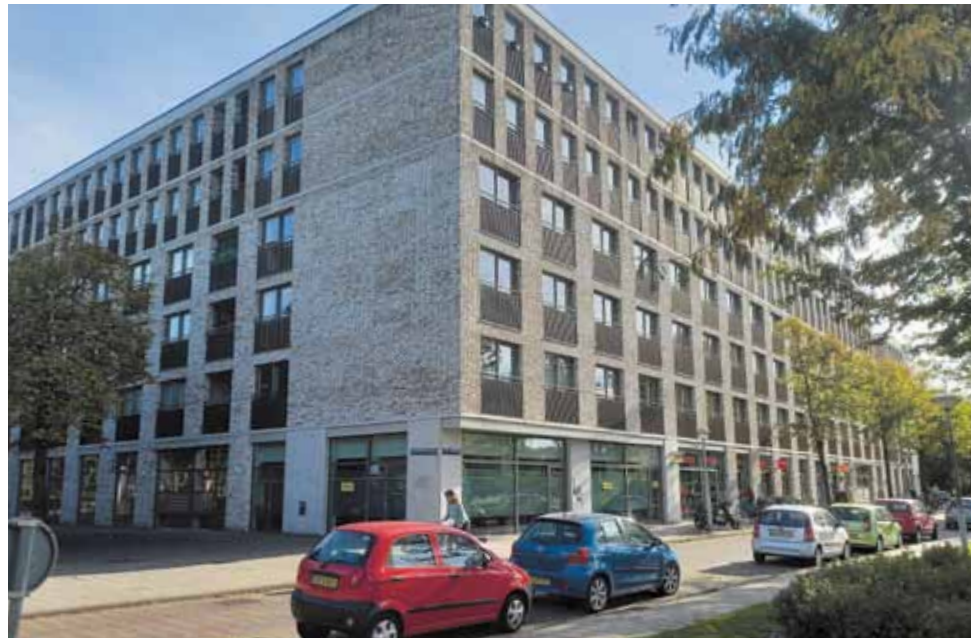
Jeruzalem Staete met op begane grond bewonersruimte en wijkcentrum
