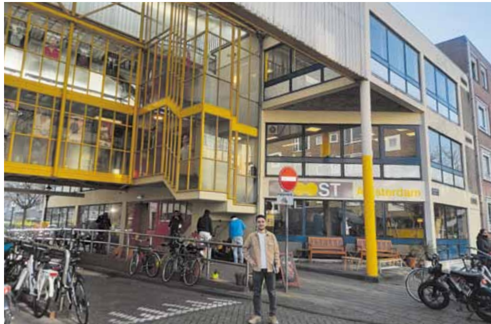
Deelnemerscoördinator Subhi Almatrouf voor het monumentale gebouw
